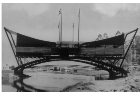
Figura 4 – Fotografia do edifício
