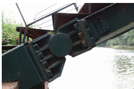
Figura 5 – Fotografia da junção base/arco
