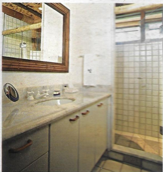
Note que o bambu arremata o alto das portas de vidro (Blindex) do boxe do banheiro.
