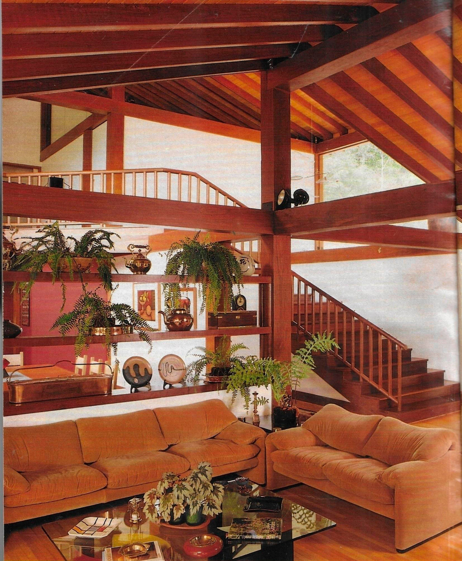
No hall de entrada, o madeiramento de maçaranduba que sustenta a cobertura delimita as divisórias de alvenaria. Entre o estar e o jantar,
