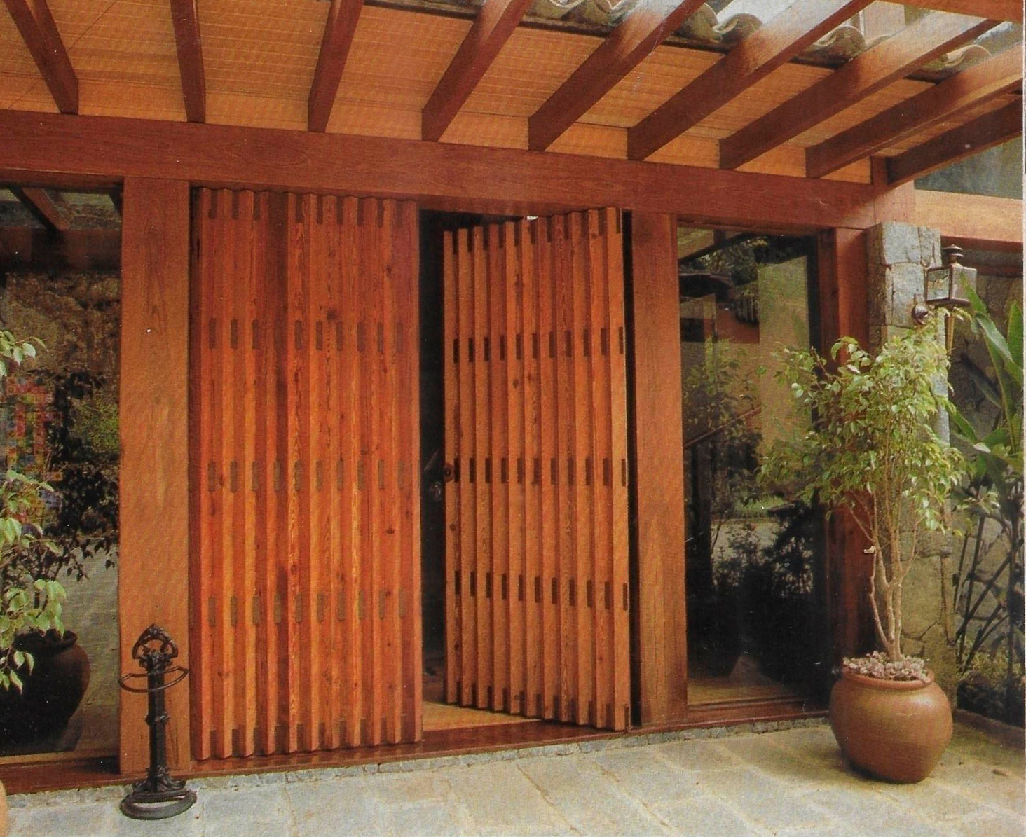
Toras chanfradas compõem a porta social, de duas folhas, cujo sistema pivotante de abertura a torna especial.
